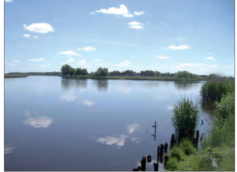
Bald nicht mehr zu befahren? Mündung des Gieselaukanals (rechts) in die Eider Foto: Jürgen Oetting / Wikipedia
